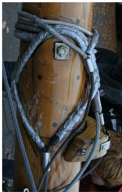
Abb. 2 Hangeranordnung am Mast
